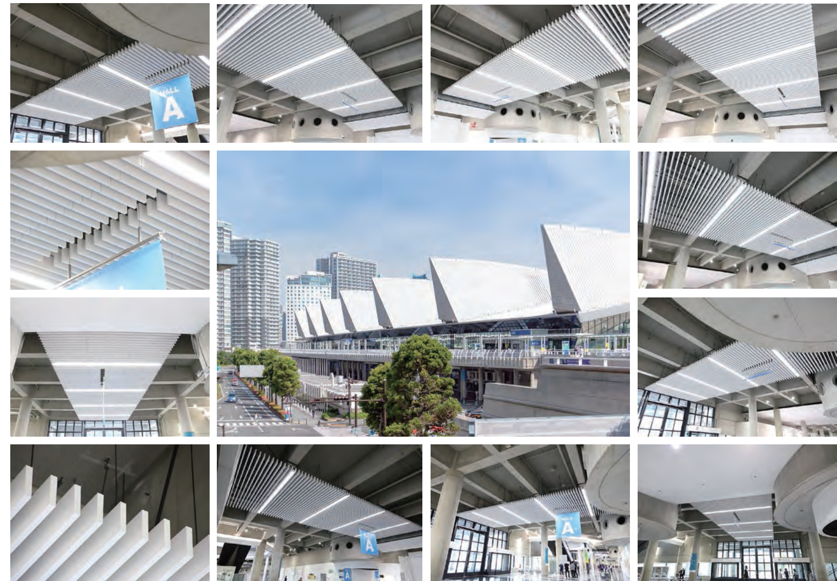
横浜みなとみらい・パシフィコ横浜展示ホール(1F・ゲート)・シーレックス・バッフル天井パネル
