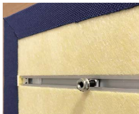
埋込みレール・内ナット・ボルト・ブラケット取付用ナット
